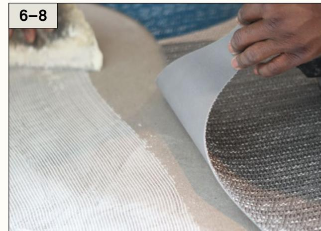
6. Terminez la pose en couvrant la zone entre la ligne de référence et le mur de base. Soyez attentif à la queue de la dalle, qui est relativement flexible et qui peut donc bouger sur le plan horizontal.
